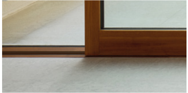
Nedsänkt tröskel i golvet.
